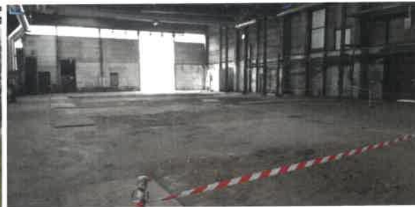
Bâtiment de la chaufferie principale
